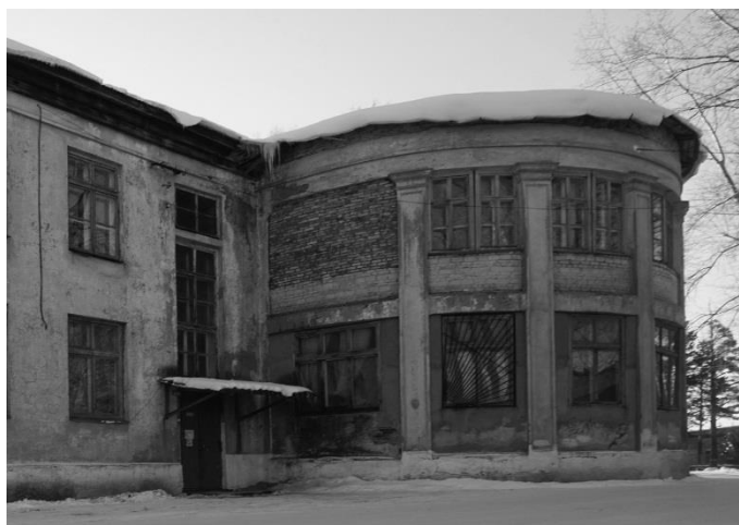
Рис. 5. Больница в Верхнем Уфалее. Фотография К.Д. Бугрова, 2018 г. Fig. 5. Hospital in Verkhniy Ufaley
